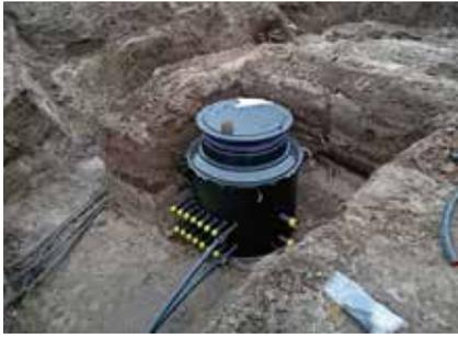
Kein Ufo – sondern der zentrale Schacht der neuen Wärmepumpe: Hier laufen die Erdsonden zusammen
