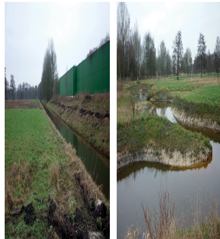
Der schnurgerade Abschnitt des Embser Mühlengrabens neben der Lärmschutzwand (links) ist in einem Kooperationsprojekt zwischen Bremen und Niedersachsen (Kreis Verden) unter Begleitung des TNU e.V. durch den Bremischen Deichverband am rechten Weserufer naturnah in Mäanderform (rechts) umgestaltet worden. (Fotos: TNU: Treffpunkt Natur und Umwelt e. V.)
